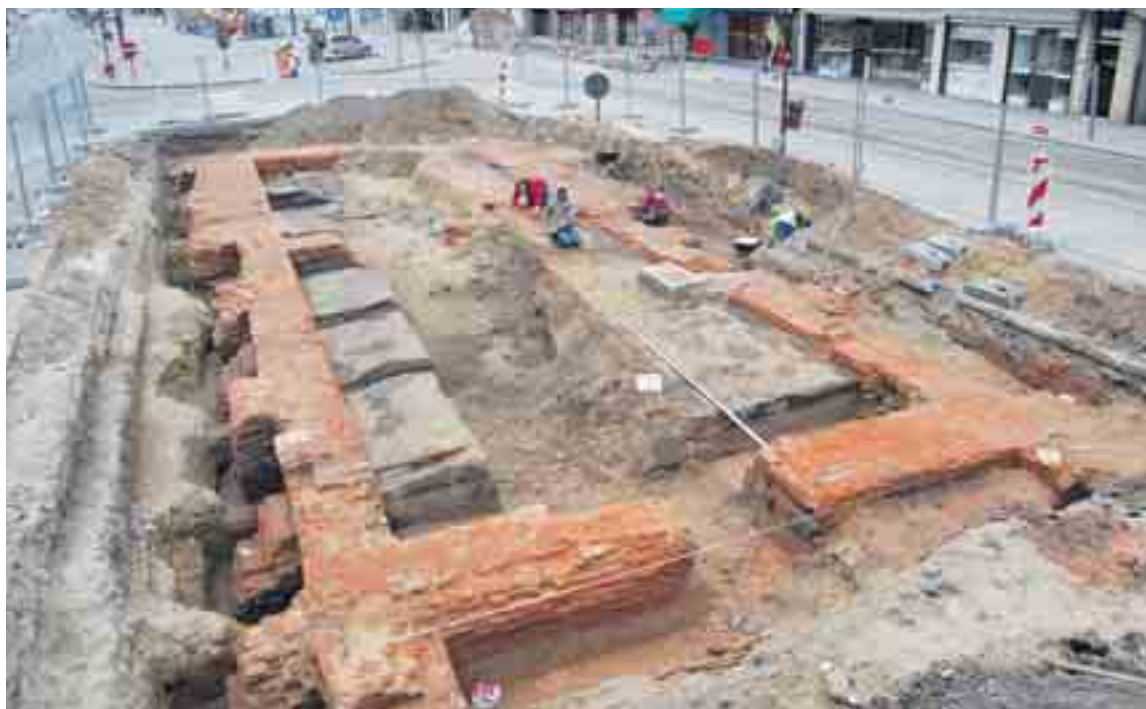
De funderingen van de in 1792 verwoeste stadshal tonen een gebouw van zowat 23 meter bij 8,5 meter. © jdv
