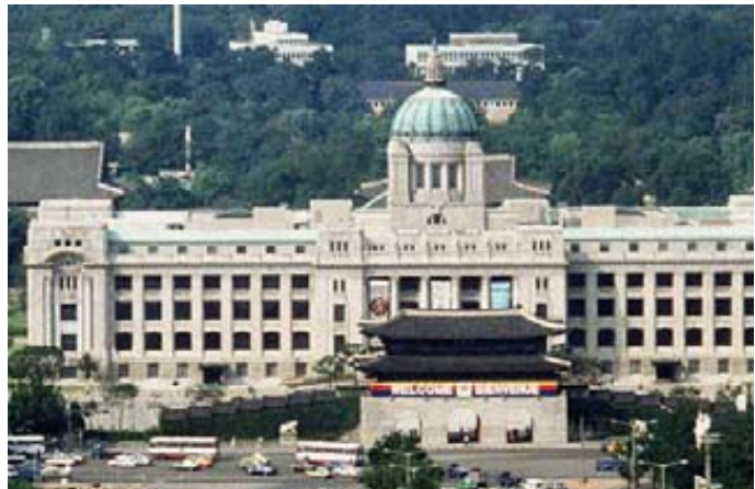
Het Cho-sun Government-General-gebouw voor de afbraak. Het was gesitueerd vlak voor het grote paleis van de Cho-sun dynastie, en dat was de hoofdreden voor de sloop.
